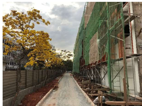
12 – Montagem do brise externo, pavimentação com blocos de concreto e meio fio.
