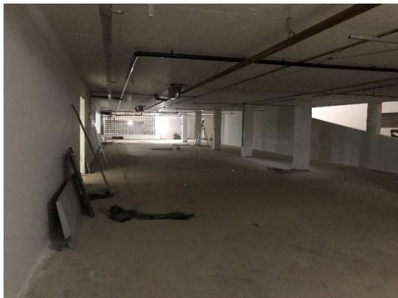
11 – Pintura de teto em concreto.
