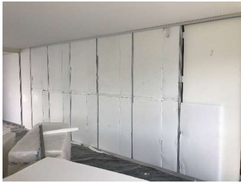
15 – Revestimento acústico das divisórias.
