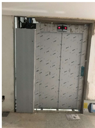
04 – Montagem de elevadores.
