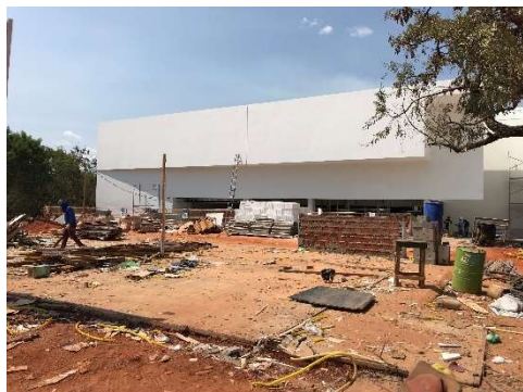
01 – Retirada do canteiro e pintura da fachada.
