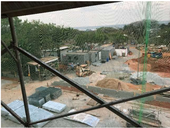
09 – Montagem do novo canteiro.
