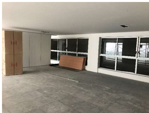
02 – Colocação de esquadrias externas e divisórias.
