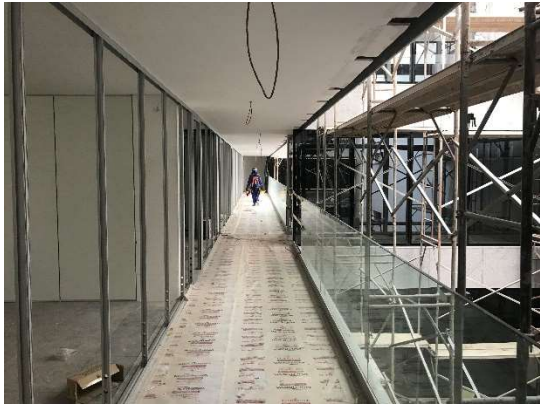
07 – Instalação de divisórias de vidro, guarda-corpo e forro com emassamento e pintura.
