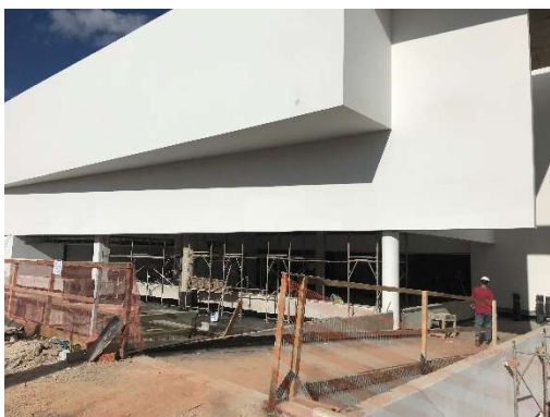
17 – Execução de rampa de entrada, pintura de fachada, impermeabilização de área de jardim .
