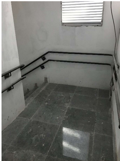
13 – Patamar de granito das escadas e corrimão.
