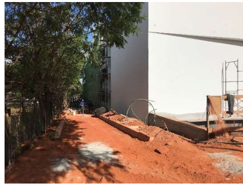
16 – Compactação do solo, meio fio de concreto e pavimentação com bloco de concreto.
